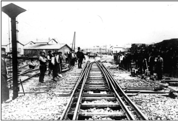
Figure 3. Essais de pose d'une voie à 4 files de rails à Draguignan, en 1889-1890. Coll. Paul Carencio, cl. d.r.
